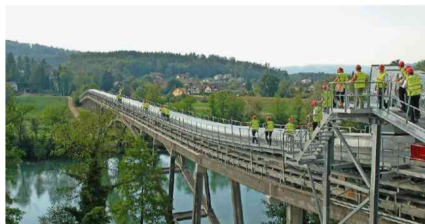
Unten kommt Rohstoff aus dem Steinbruch, oben wird mit dem neuen Förderband das Material für das Wiederauffüllen von Wildeggen in die Oberegg transportiert.
